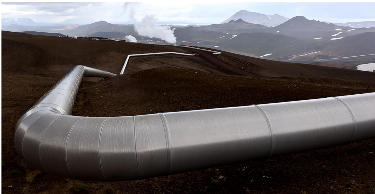
Газопровод «Сила Сибири».
