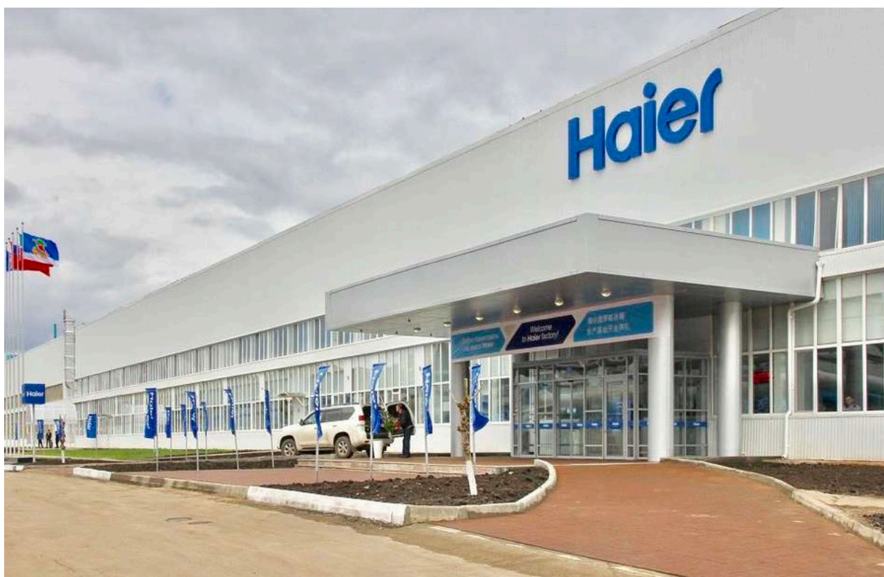
Завод компании Haier в г. Набережные Челны.
