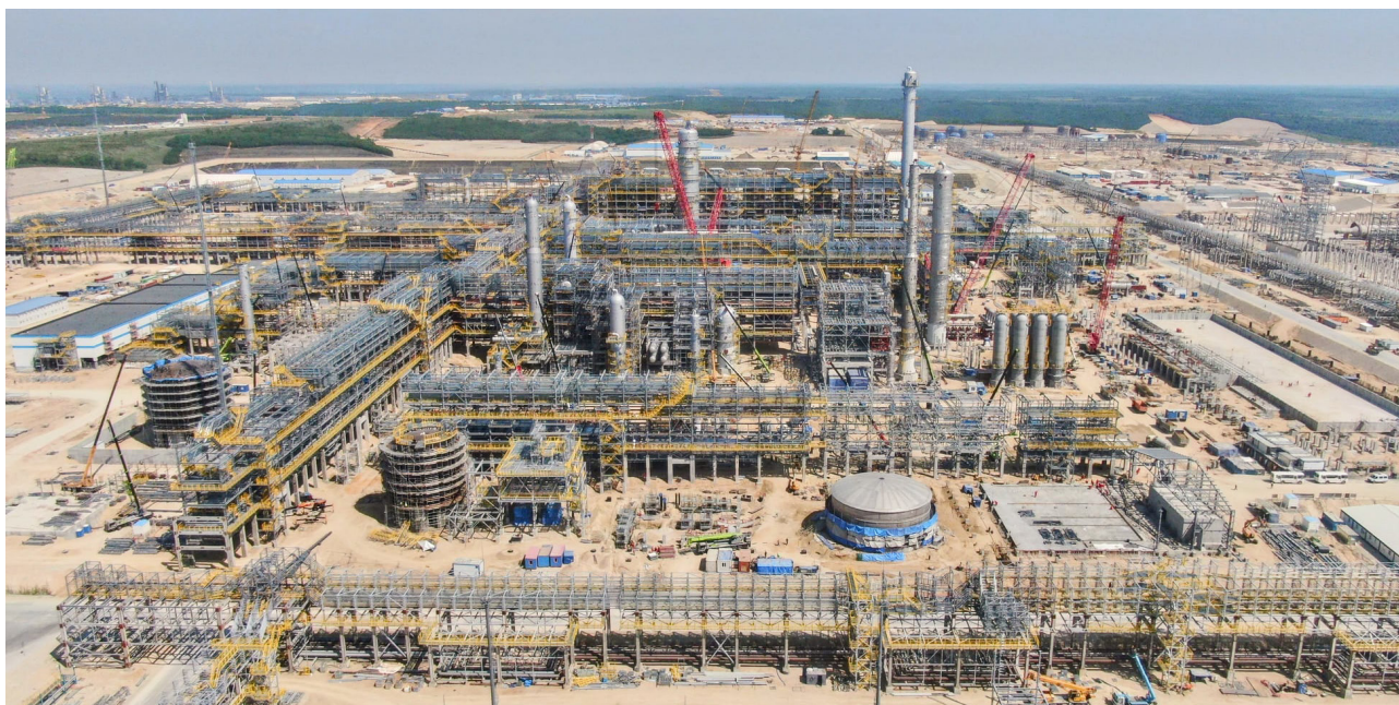
Строительство Амурского газохимического комплекса (июнь 2024 года).
