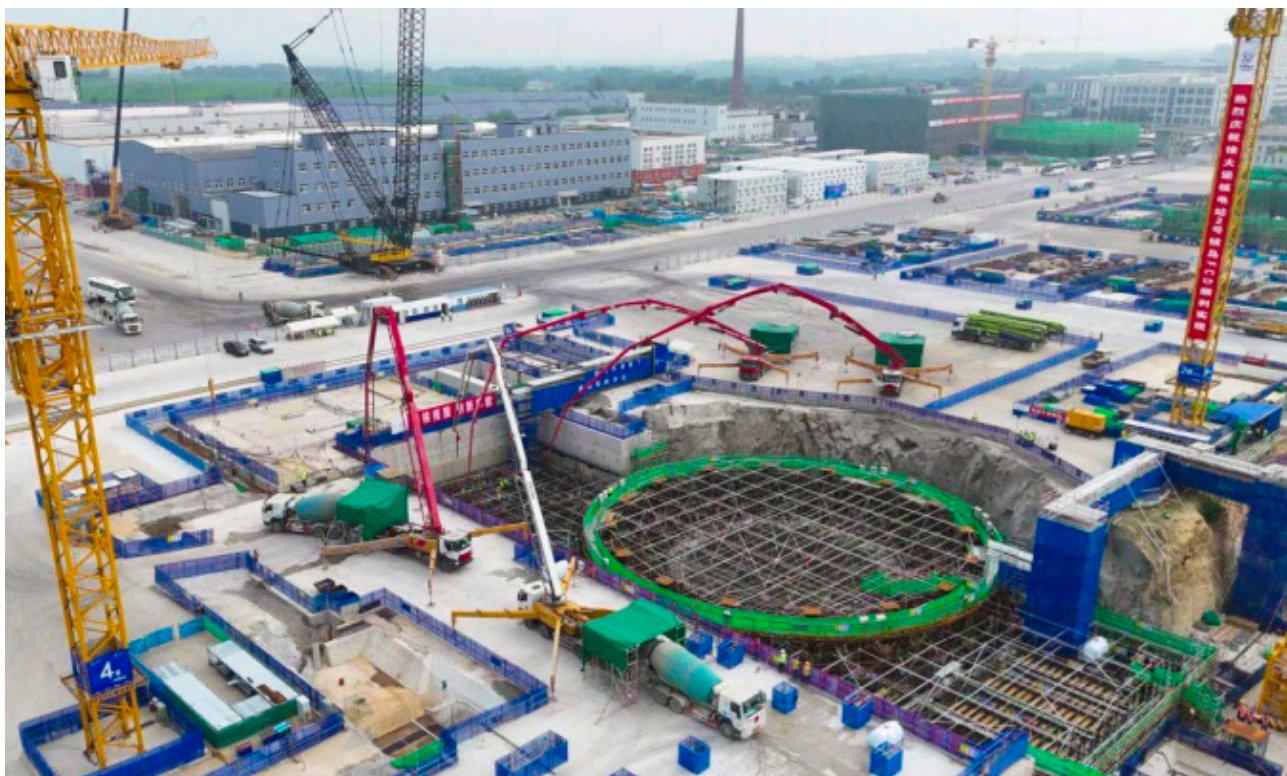
Строительство АЭС «Сюйдапу» (июль 2024 года).
