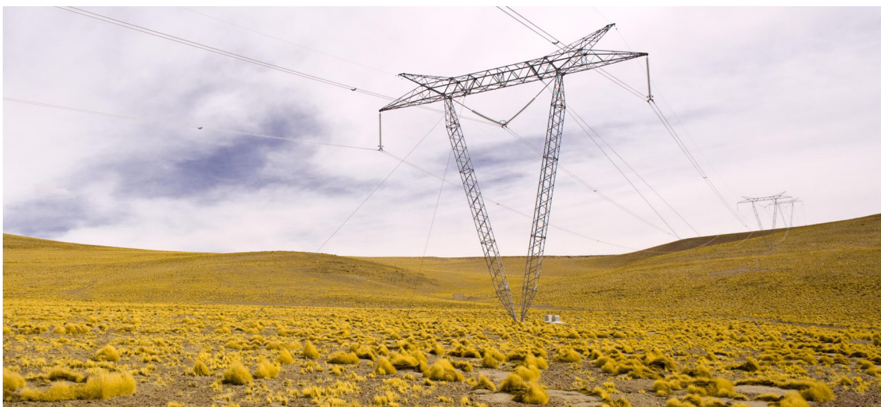
ЛИНИИ ЭЛЕКТРОПЕРЕДАЧ В ПУСТЫНЕ АТАКАМА, ЧИЛИ
