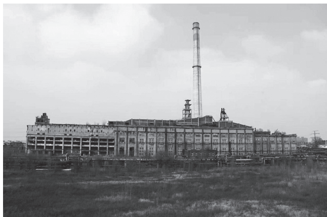
插图1, 中国-辽宁省-抚顺市, 大官屯发电所-主体建筑, 王一恒, 摄于2018年
