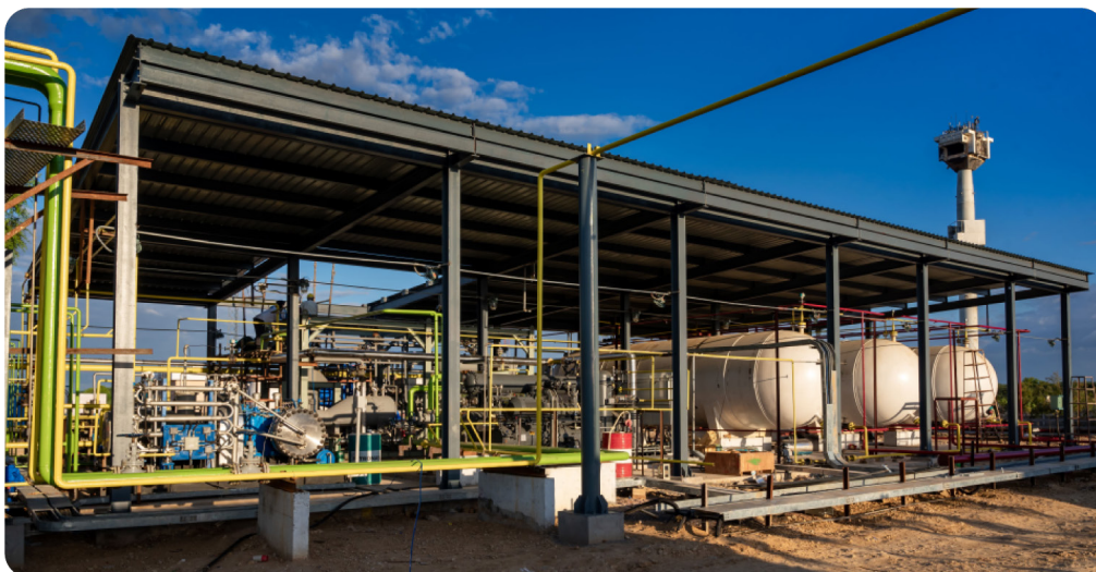
Электролизный завод в Индии для производства зеленого водорода
