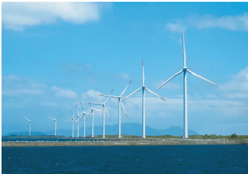
Рис. 2. 10 ветряных турбин электростанции Хибикинада (вид с моря).
