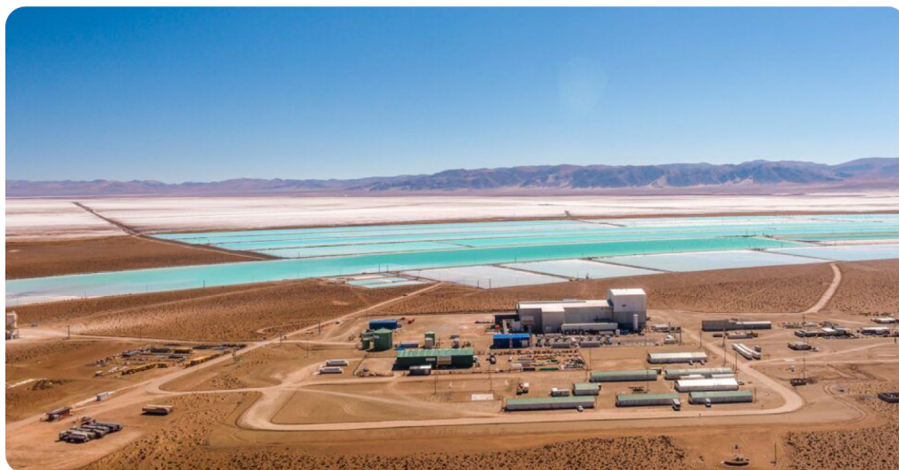
Рассольные бассейны и зона переработки на литиевом месторождении в Аргентине, акционер Jiangxi Ganfeng Lithium Co. Ltd. из Китая.
