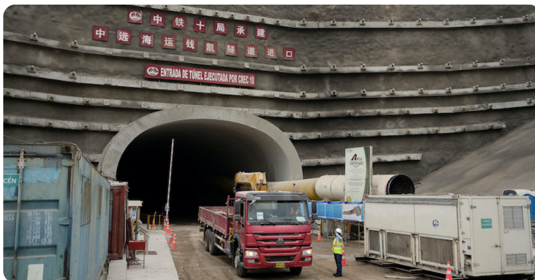
Строительство нового китайского мегапорта в Чанкай, Перу.
