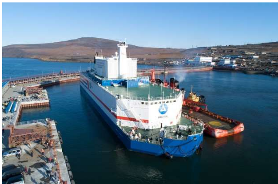
Рис. 3. Плавучая атомная теплоэлектростанция «Академик Ломоносов». Источник: https://www.rosatom.ru
